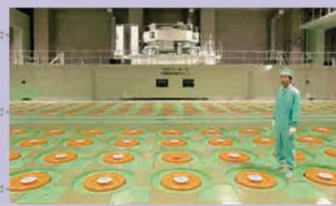
ガラス固化体の貯蔵ピット
